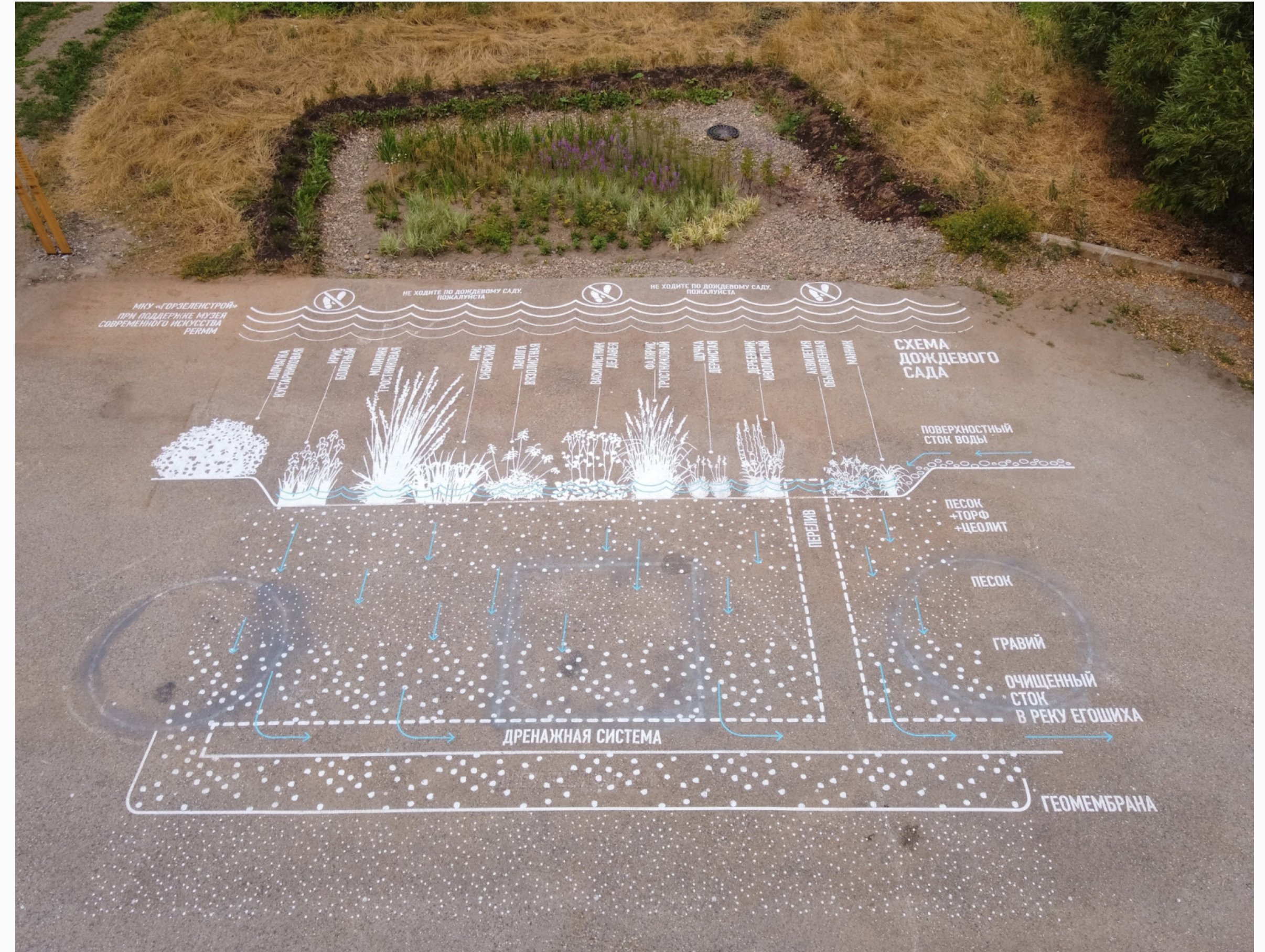
Дождевой сад в долине реки Егошихи, Пермь. Дождевые сады фильтруют воду и уводят ее на уровень грунтовых вод или в водные объекты при помощи дренажных труб
